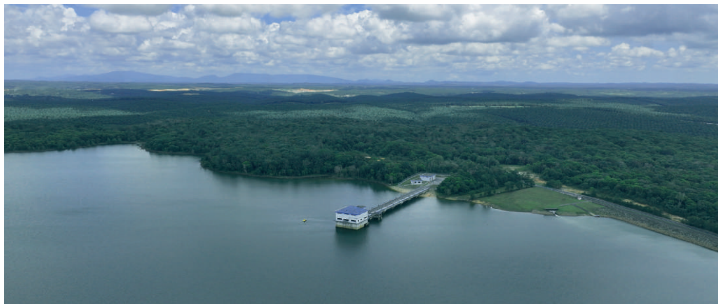
Sungai Layang Dam, Johor
