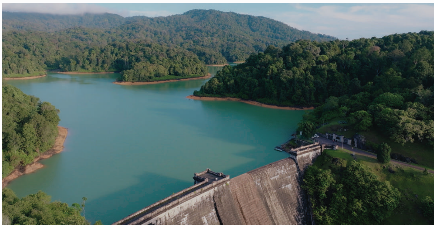
Gunung Pulai Dam, Johor
